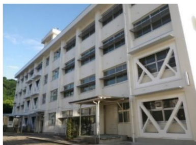
▲ 耐震化された校舎
