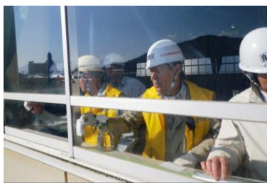
▲ 地区の自主防災組織と連携し、小中学校体育館窓ガラスに飛散防止フィルム貼付け
